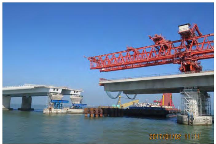
沿用傳統節段拼裝方法，可惜沒有利用海上可運輸大型構件優勢，整個橋面一次吊裝，以節省施工期
