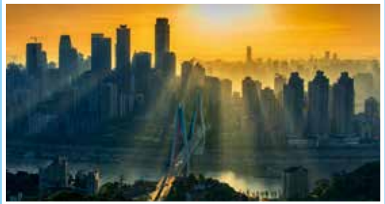
東水門長江大橋
