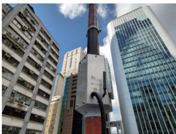
已安裝的智能通風管淨化器
